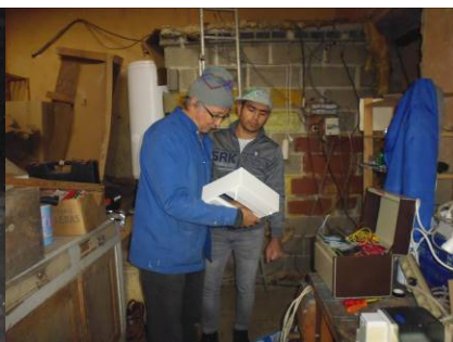
Les électriciens au premier
