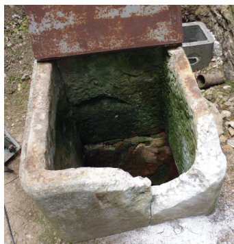
Margelle endommagée
