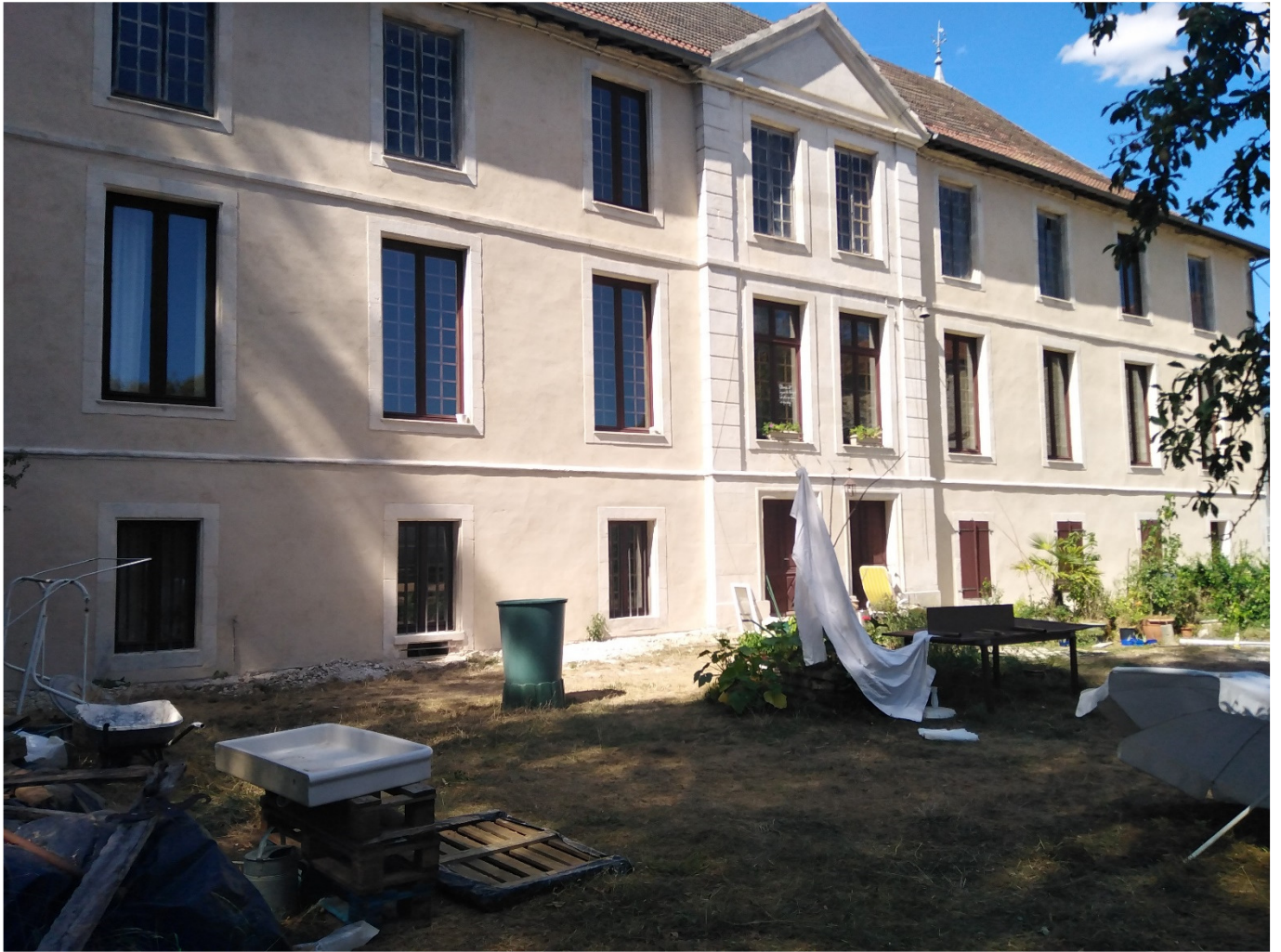
Erster Tag ohne Gerüst. Wir bewundern die Fassade und vergessen das „Chaos“
