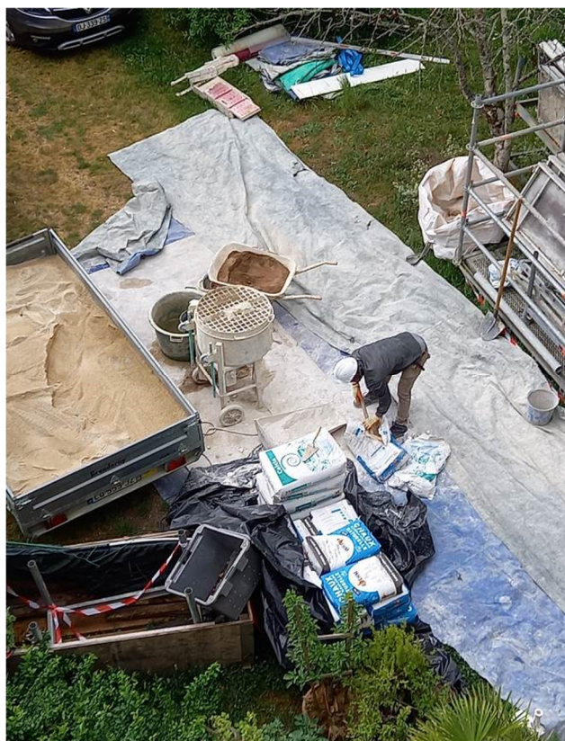
André hievt die Eimer mit einem Flaschenzug hoch, Oumar bereitet den Kalkverputz mit dem Betonmischer zu
