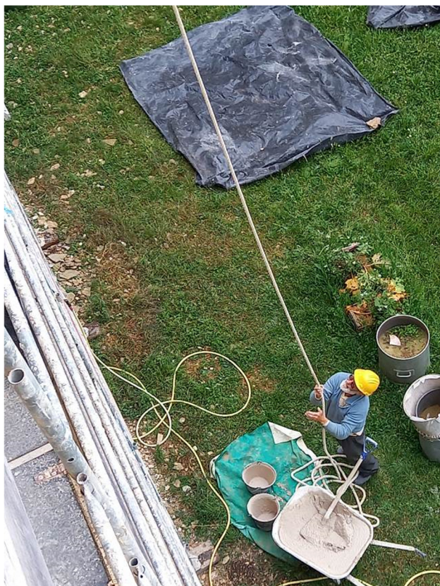
André hievt die Eimer mit einem Flaschenzug hoch, Oumar bereitet den Kalkverputz mit dem Betonmischer zu
